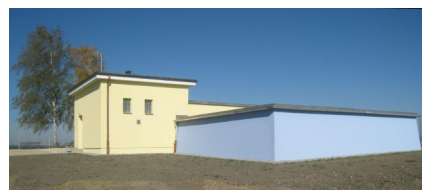
Sicherung der Trinkwasserversorgung durch Renovierung des Hochbehälters
