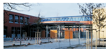
Schule, Eingang Aula und neuer Innenhof
