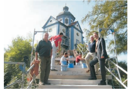
Sanierung wichtiger Treppen
